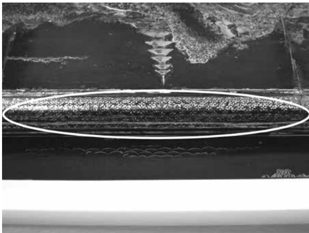
写真 32 目違いで蓋鬘が外に出ていた
