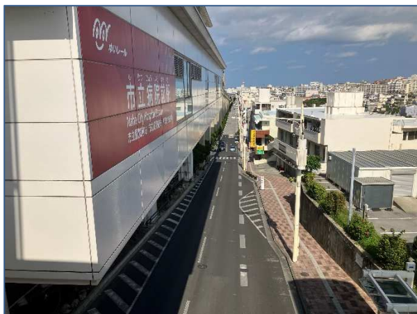
図5-5 施工事例 県道82号線（那覇市首里末吉町） ※都市計画道路名：那覇糸満線
