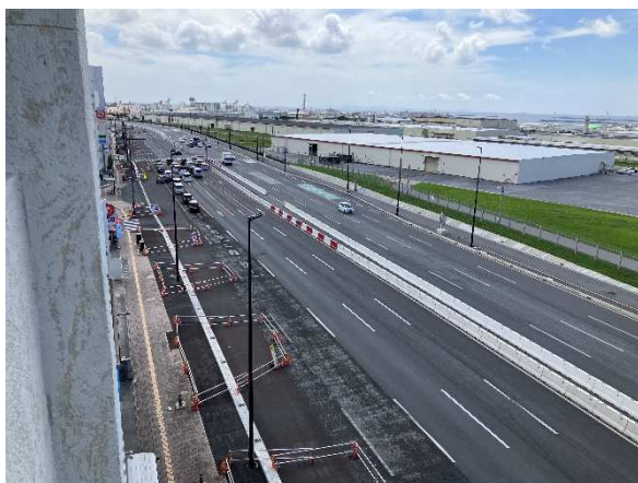
図2-1 国道58号 那覇方面(浦添市内)
