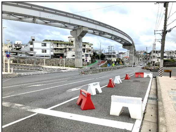
図3-1 市道国際センター線(前田) ※都市計画道路名：国際センター線
