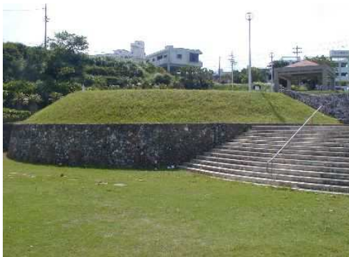
3. 浦仲配水池 (容量5,000m 3 )
