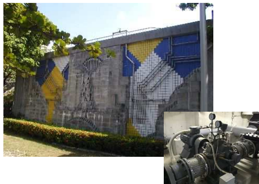
4. 浦仲中継ポンプ施設
