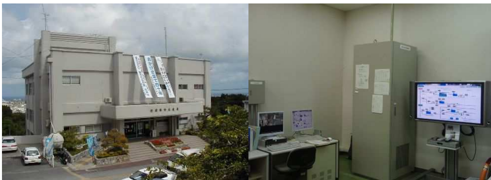
7. 中央監視室 (上下水道部庁舎内)
