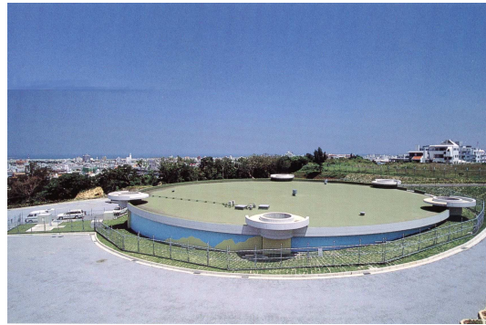
2. 沢岬配水池 (容量11,000m 3 )
