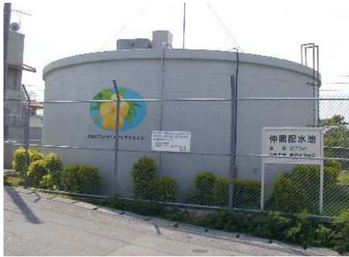
1. 仲間配水池 (容量273m 3 )
