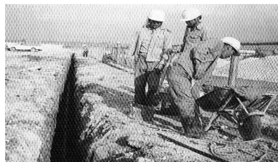
手作業による配水管布設工事
