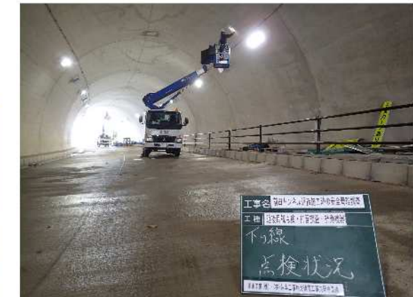
下り線点検状況 (H30年3月撮影)
