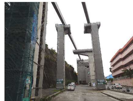
終点側モノレール架設状況 (H30年3月撮影)
