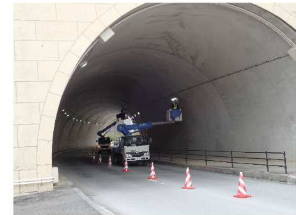
上り線点検状況 (H30年3月撮影)
