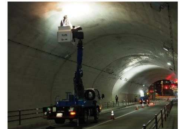
側壁点検(高所作業)
