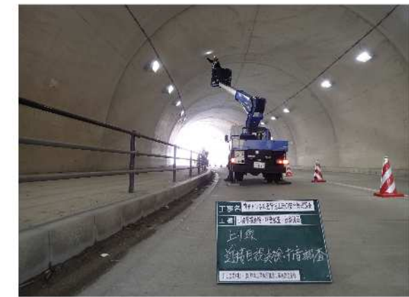
上り線点検状況 (H30年3月撮影)
