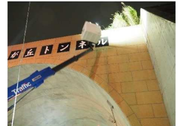
坑門工点検(高所作業)
