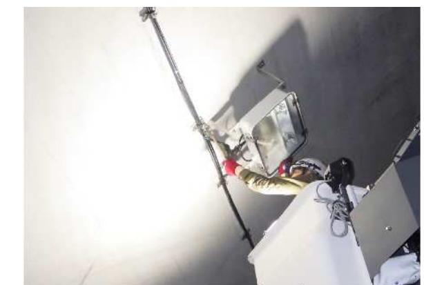
打音検査(高所作業)
