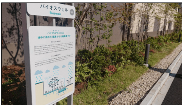
民有地内に整備されたバイオスウェル
