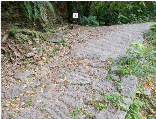
石畳上に舗装されたコンクリート (南側入口付近の斜面)
