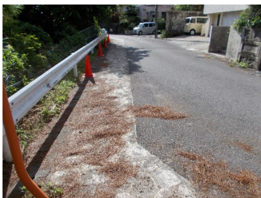
石畳ルート舗装整備状況（経塚）
