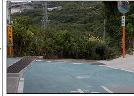
車止めの設置
