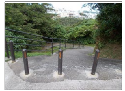
車止めの設置
