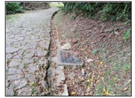
排水施設整備
