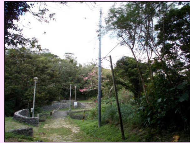
既設電柱の撤去・地中埋設化
