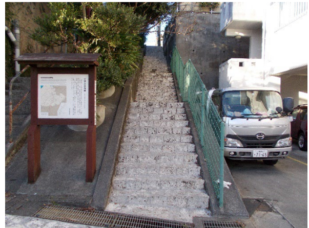
石畳風舗装整備済み箇所 (ニシヌヒラ付近)
