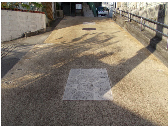
カラーアスファルト舗装整備済み箇所 (ニシヌヒラ付近)
