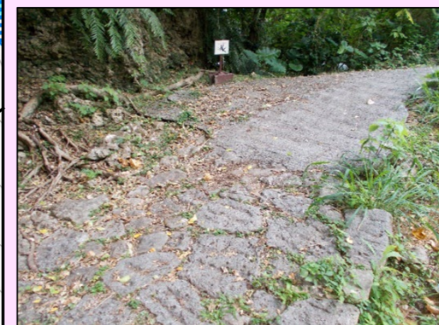
南側入口付近のコンクリート舗装下の石畳復元整備
