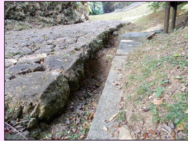
洗掘による被害箇所の復元整備
