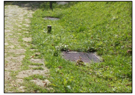
排水施設整備
