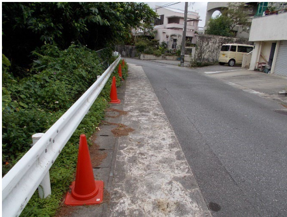
石畳風舗装整備済み箇所 (中頭方西海道南側入口付近)
