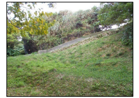
擁壁・転落防止柵整備
