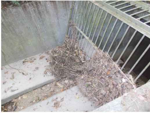
導水トンネル入口
