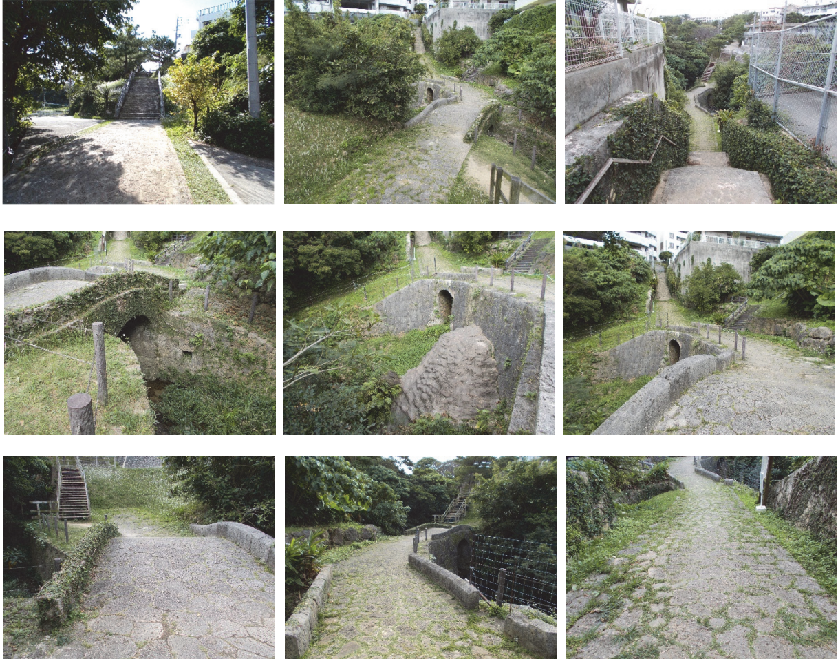
安波茶橋修復工事概要一覧表
