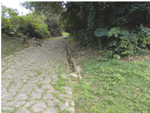
石畳道と排水施設の状況
