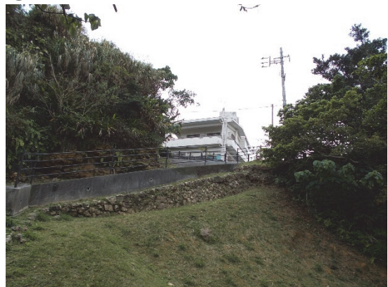
南側入口と斜面が確認できる。
