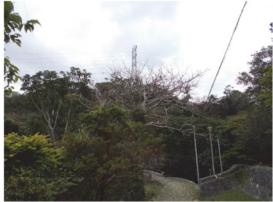
当山橋、小湾川、緑地景観が確認できる。
