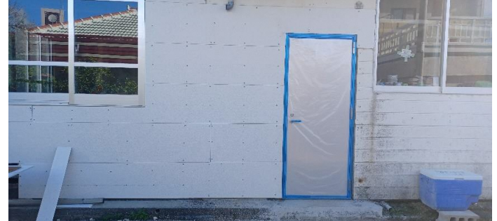
玄関アルミドア・窓取り付け
