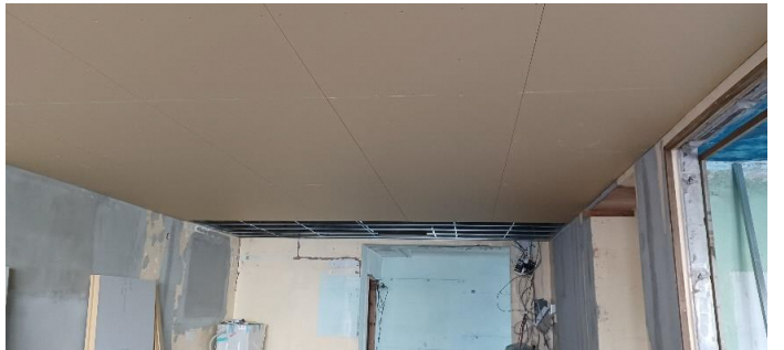
天井板取り付け
