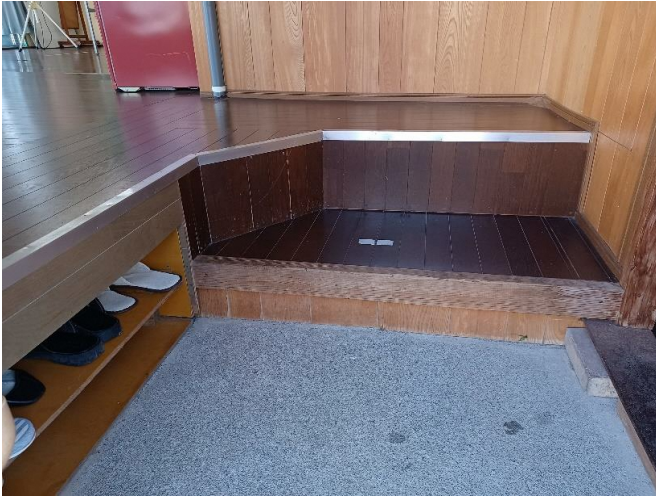
床が高く上がり降り時危ない
