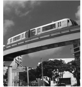
延伸する沖縄都市モノレール
