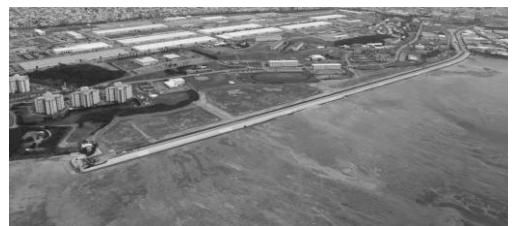
整備中の西海岸道路
