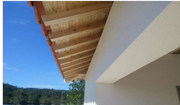
木造庇とコンクリートの混構造
