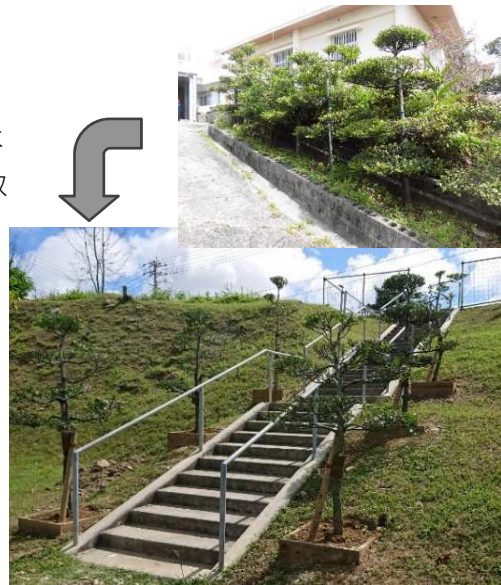
不要樹木移植による 公共施設内での再活用
