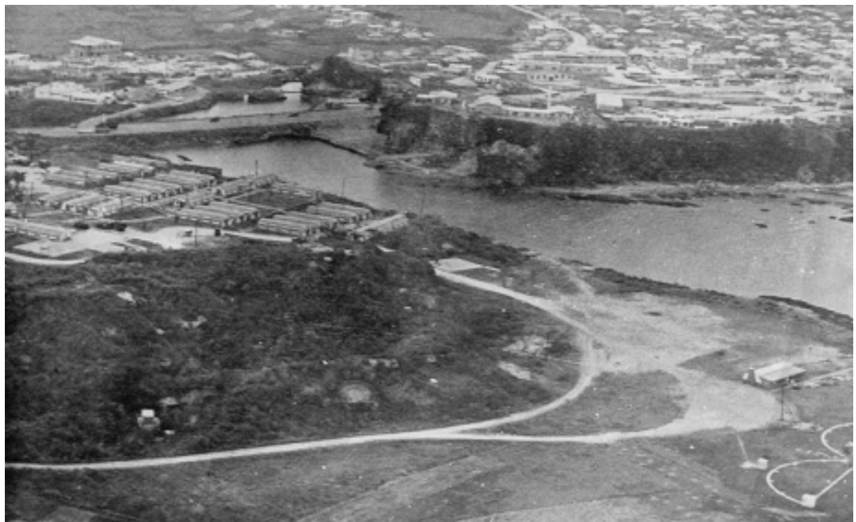
P L.46 「牧港」昭和 36 年 撮影／山内良好 1961 年 琉球政府発行『琉球のあゆみ 10・11 合併号』より転載。 宇地泊上空から牧港岩山一帯を撮影。牧港橋や軍道一号線、入江の様子、牧港岩山頂部の教会などが確認できる。
