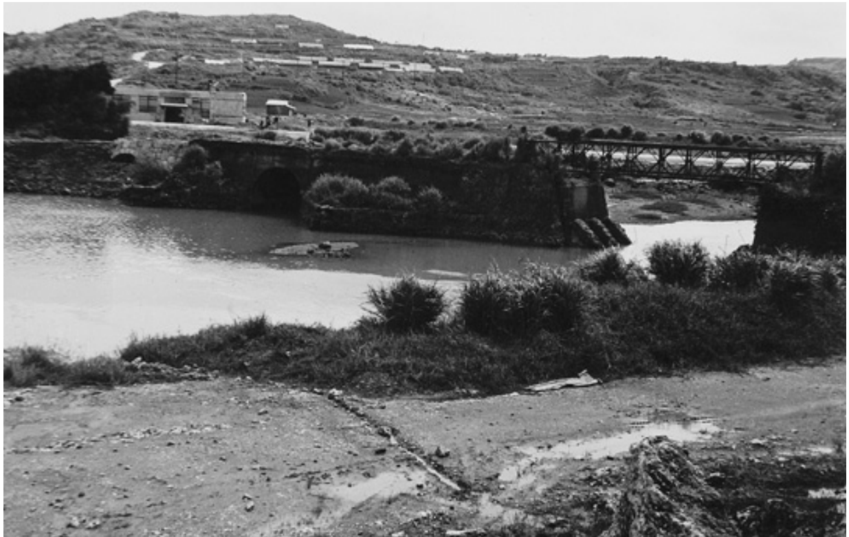
P L .43 昭和 27 年 撮影／太宰好夫 浦添市立図書館沖縄学研究室所蔵 写真左側の建物は牧港ポンプ場で、右側は牧港橋。牧港岩山の崖下から嘉数方面を撮影。
