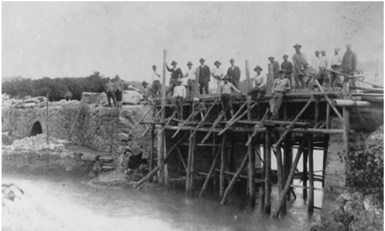
P L .33 昭和 10 年 写真提供／澤岷勝雄氏 牧港橋補修工事の様子（P L . 32 の崩落したレンガ橋の補修工事）。この工事に関わった 牧港在住の又吉盛秀氏（大正 9 年生）によると、橋は工事終了後、一週間もしないうちに 崩れてしまい、再度、補修されたという。
