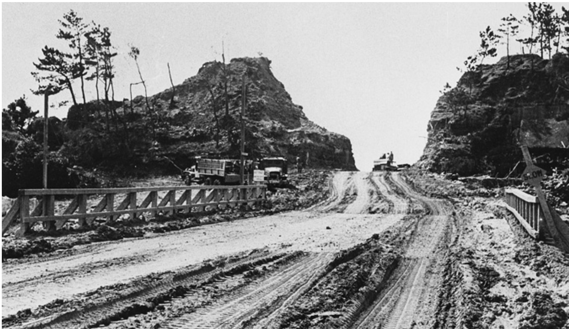
P L.40 昭和 20 年 月刊沖縄社『日本最後の戦い』1977 年発行 軍道一号線工事状況。写真手前側の鉄橋は牧港橋の一部で、戦時中に米軍が架橋した。写真左側の丘陵は、今日、県道 153 号線が開通して 住宅地が広がり、この写真の面影を全く残していない。
