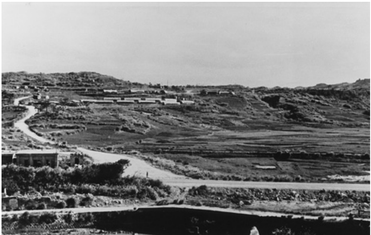
P L .42 昭和 23 年 撮影／宮城良雄 浦添市牧港自治会所蔵 牧港ポンプ場と牧港橋。写真中央付近は戦前の軽便鉄道跡。左側上部は嘉数高地（高台）、右側上部の丘陵は浦添グスクで、突出した為朝岩も微かに確認できる。
