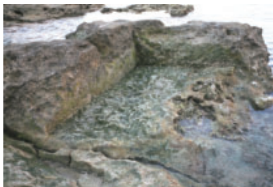
写真10 侵食された遺構面
