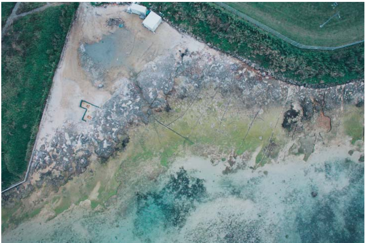
写真3 調査地 全景（上空から）
