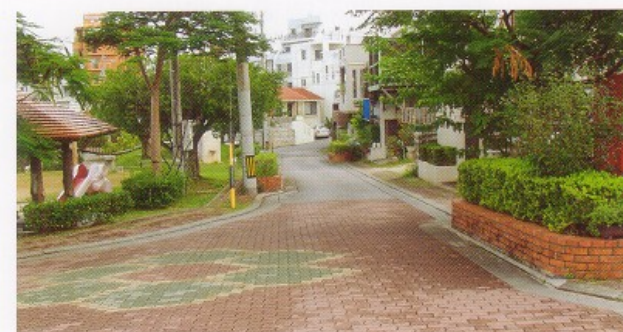
区画道路(城間・伊祖地区)
