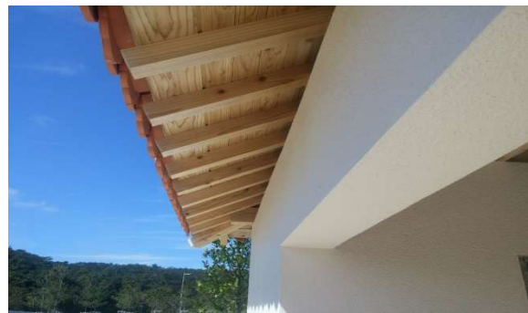
木造庇とコンクリートの混構造
