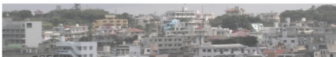
勾配屋根と陸屋根、高架タンクのふぞろいな景観
