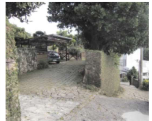
浸透性のある外構
