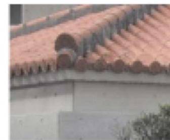
RC造打放しと赤瓦の組み合わせ
