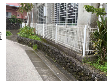
石積みの上にフェンス
