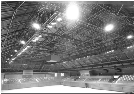
● 各種競技、イベントに対応した照明装置を整備
