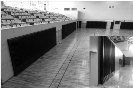
● 輻射式冷房を導入し、室内競技への影響を低減
