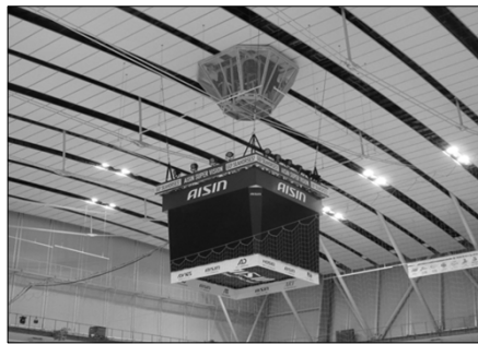
● 大型液晶ディスプレイ吊下げ用巻上機を整備 ● イベント開催に対応した音響空間確保に配慮した内装仕上
