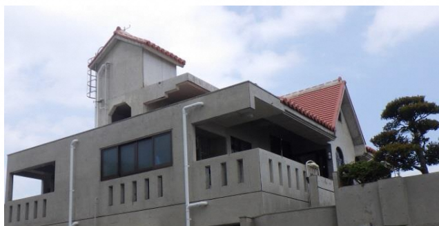
外壁と同じ仕上げで隠蔽した好ましい例
