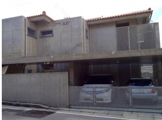
コンクリート屋根と門扉を活用し、視認性に配慮した例
