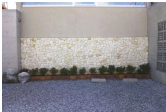
琉球石灰岩（貼付含む）
