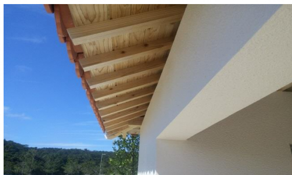
木造庇とコンクリートの混構造
