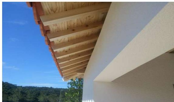
木造庇とコンクリートの混構造
