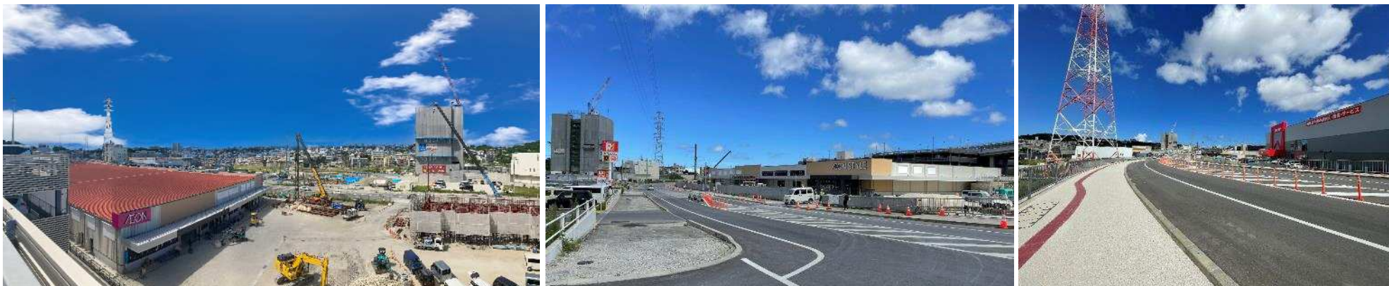
周辺の開発動向（イオン建設現場（左・中）、ヤマダ電機（右））（R6年7月3日時点）
