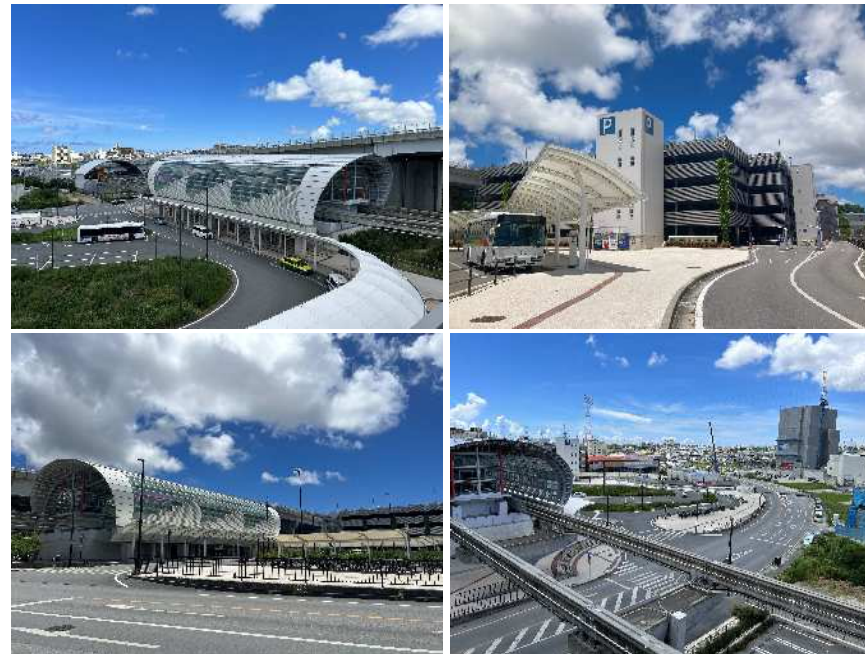
令和6年7月18日時点 てだこ浦西駅周辺の写真
